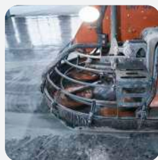
FRATASADO DE HORMIGÓN
