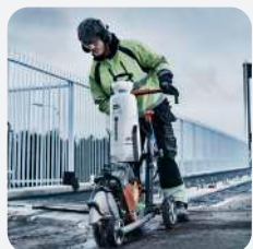
CORTE DE ASFALTO
