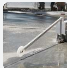
REPARACIÓN DE JUNTAS
