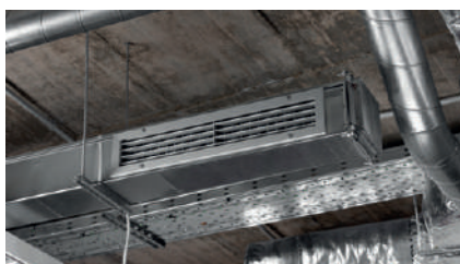
Montaje de conductos de aire acondicionado. Instalação de condutas de ar condicionado.
