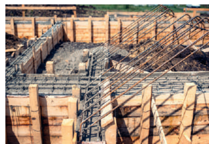
Clavado de listones de rastrel en hormigón. Pregagem de ripas ao betão.
