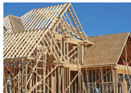
Construcción madera. Construção em madeira.
