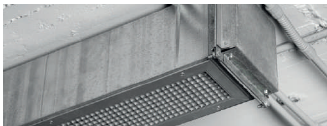
Fijación de estructuras. Fixação de estruturas.
