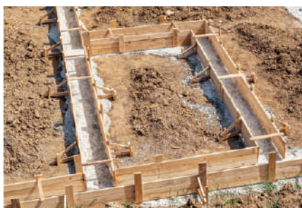
Formación de encofrados. Formação cofragens.
