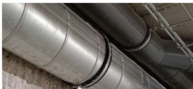
Fijación de tubos pesados de PVC, cobre y acero. Fixação de tubos de PVC pesados, tubos de cobre e de aço.
